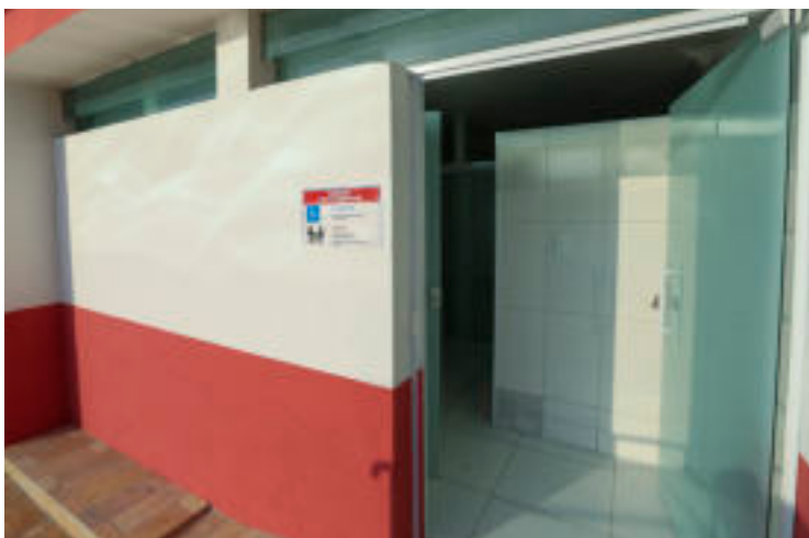
Banheiro familiar especial
